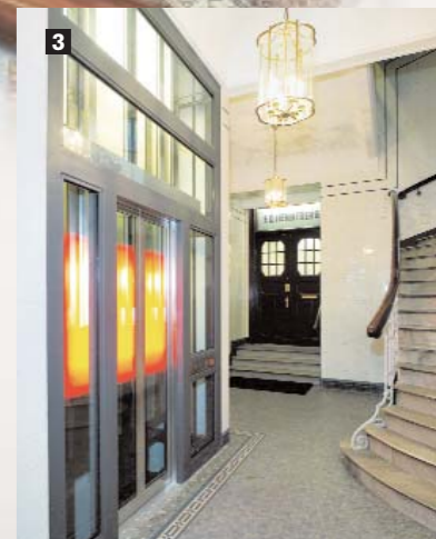
Poststraße: 3 Modernisierter Personenaufzug mit Glaseinhausung in einem Jugendstilgebäude.
