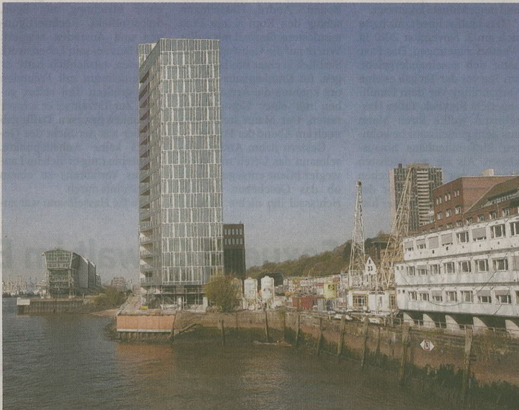
Der Wohnturm an der Großen Elbstraße ist so gut wie fertig. In wenigen Wochen fahren zwei gläserne Panoramafahrstühle die Bewohner nach oben.
